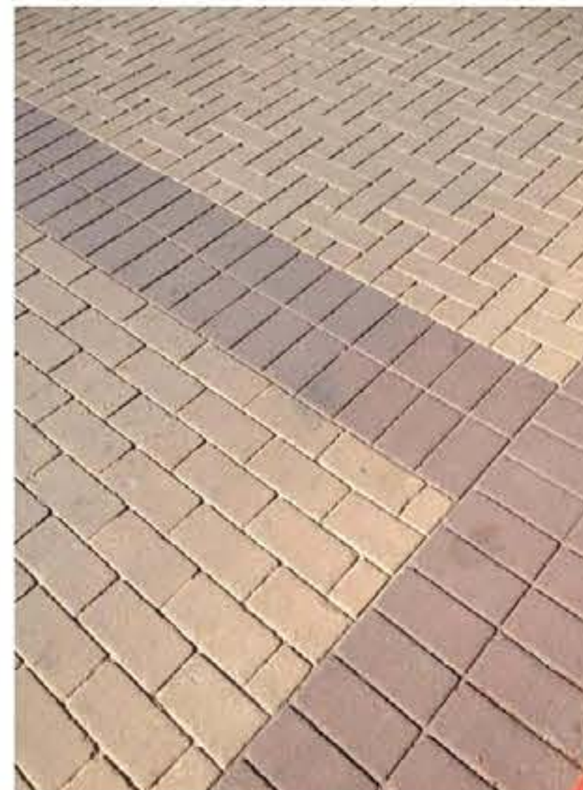
4 INTERLOCKING PAVERS* N.T.S
