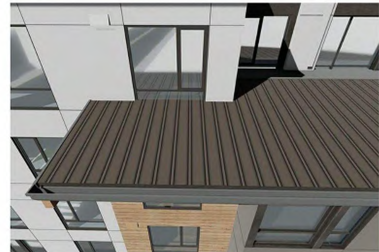
E1 STANDING SEAM METAL ROOF
